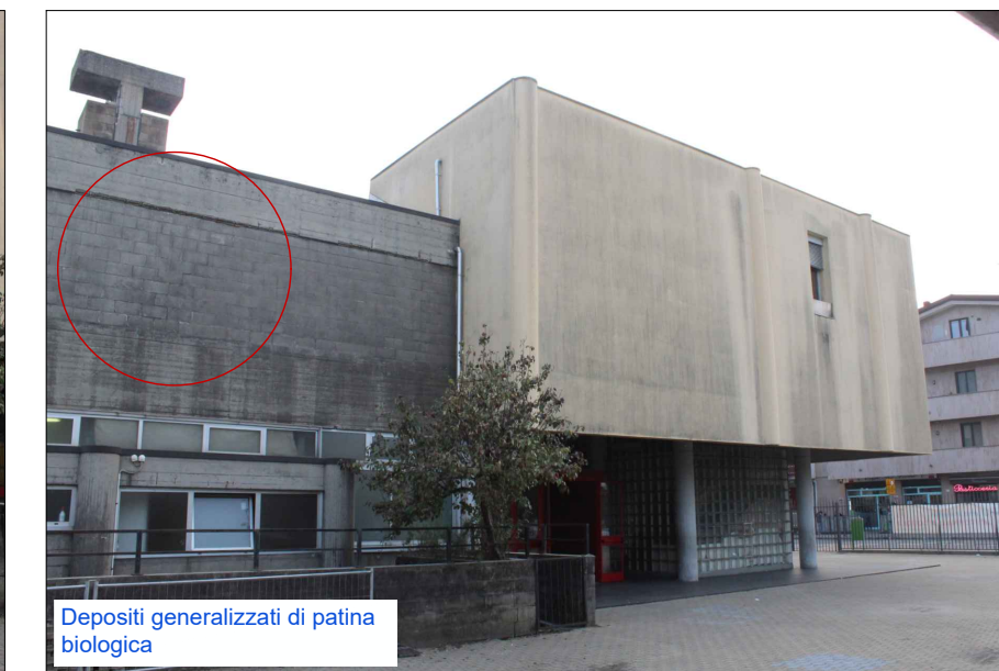
Depositi generalizzati di patina biologica
