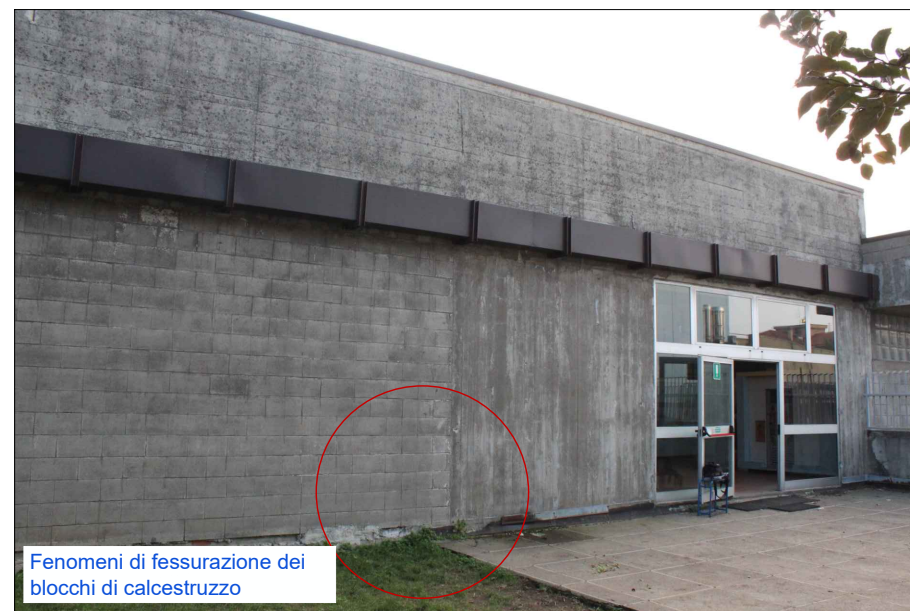
Fenomeni di fessurazione dei blocchi di calcestruzzo
