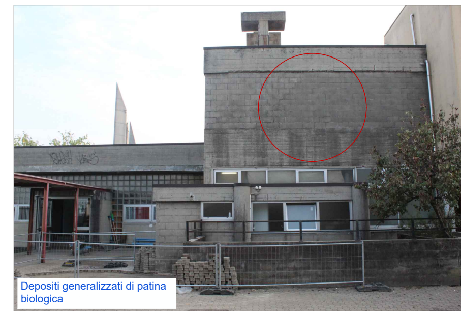
Depositi generalizzati di patina biologica
