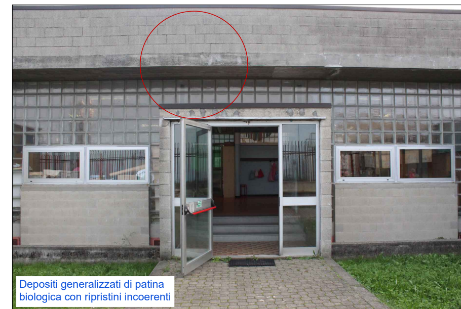
Depositi generalizzati di patina biologica con ripristini incoerenti
